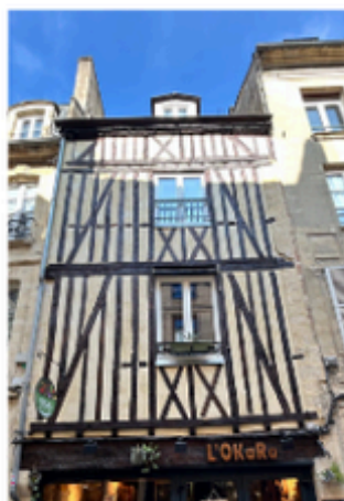
Immeuble à colombages
